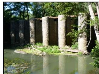
A ce titre, le Syndicat Mixte du Bassin de la Cisse prévoit l'aménagement de l'ouvrage à Poutrelles sur la commune de Vouvray en créant une ouverture en forme de « V » dans le radier de l'arche la plus large (5.20m).
